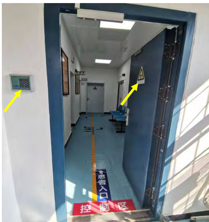
核医学科入口放射性标志和门禁 及控制区分区标志、地面引导标志
